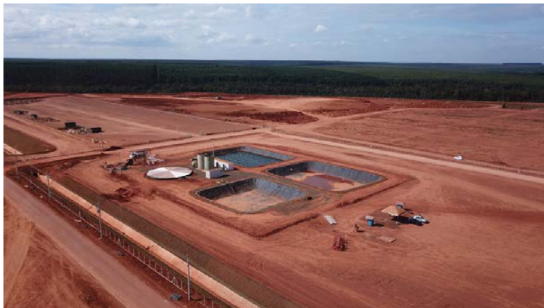
Wasser- und Abwasserbehandlungsanlage
