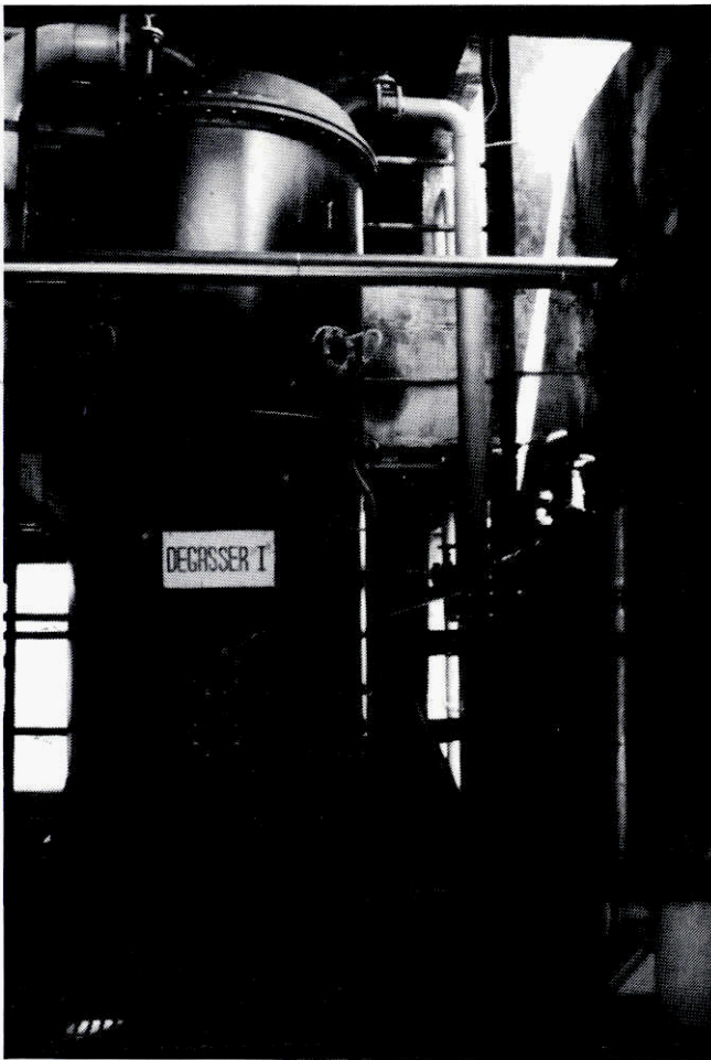
Abb. 11: Erste Stufe einer zweistufigen Entgasungsanlage
