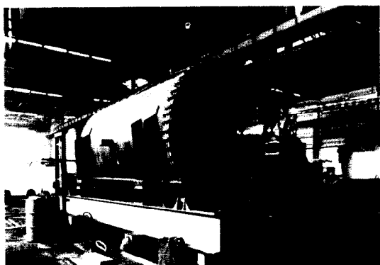
c) Foto bei Montage
