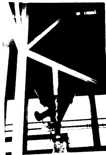
Abb. 9: Apparat, der den Rüttler ersetzt. Seine Schallwellen werden im Inneren des Silos erregt, ohne dabei die Wände zu erschüttern.
