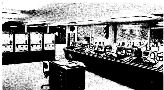
Abb. 33: Regel- und Meßzentrum einer modernen Färberei
